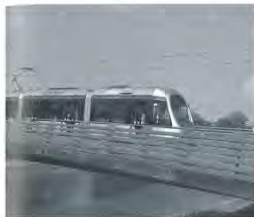
6/ Il ponte della tramvia.
