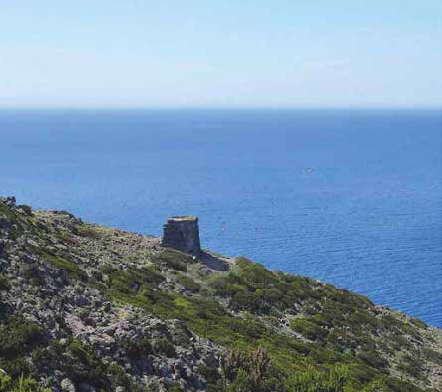
97. Isola di Capraia, la Torre della Teglia
