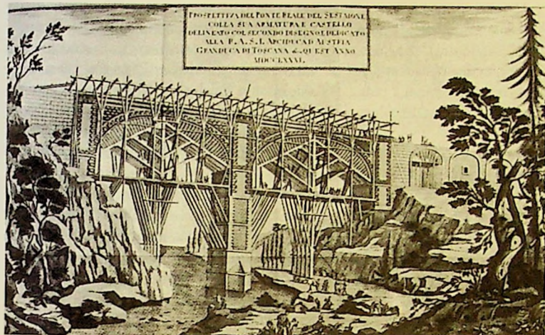
Il ponte sul Sestaione costruito nel 1779 da Leonardo Ximenes sulla transappenninica Pistoia-Abetone, in un disegno originale del suo progettista.
