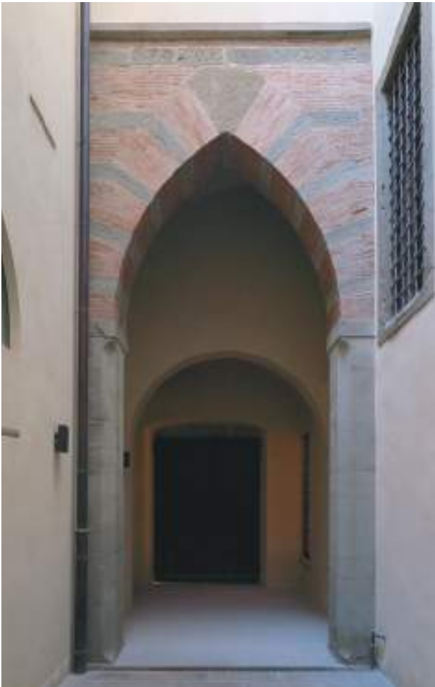
FIG. 8: Fabbricato degli Uffizi, arco a sesto acuto realizzato in leghe di pietra e laterizi con concio di chiave in arenaria
