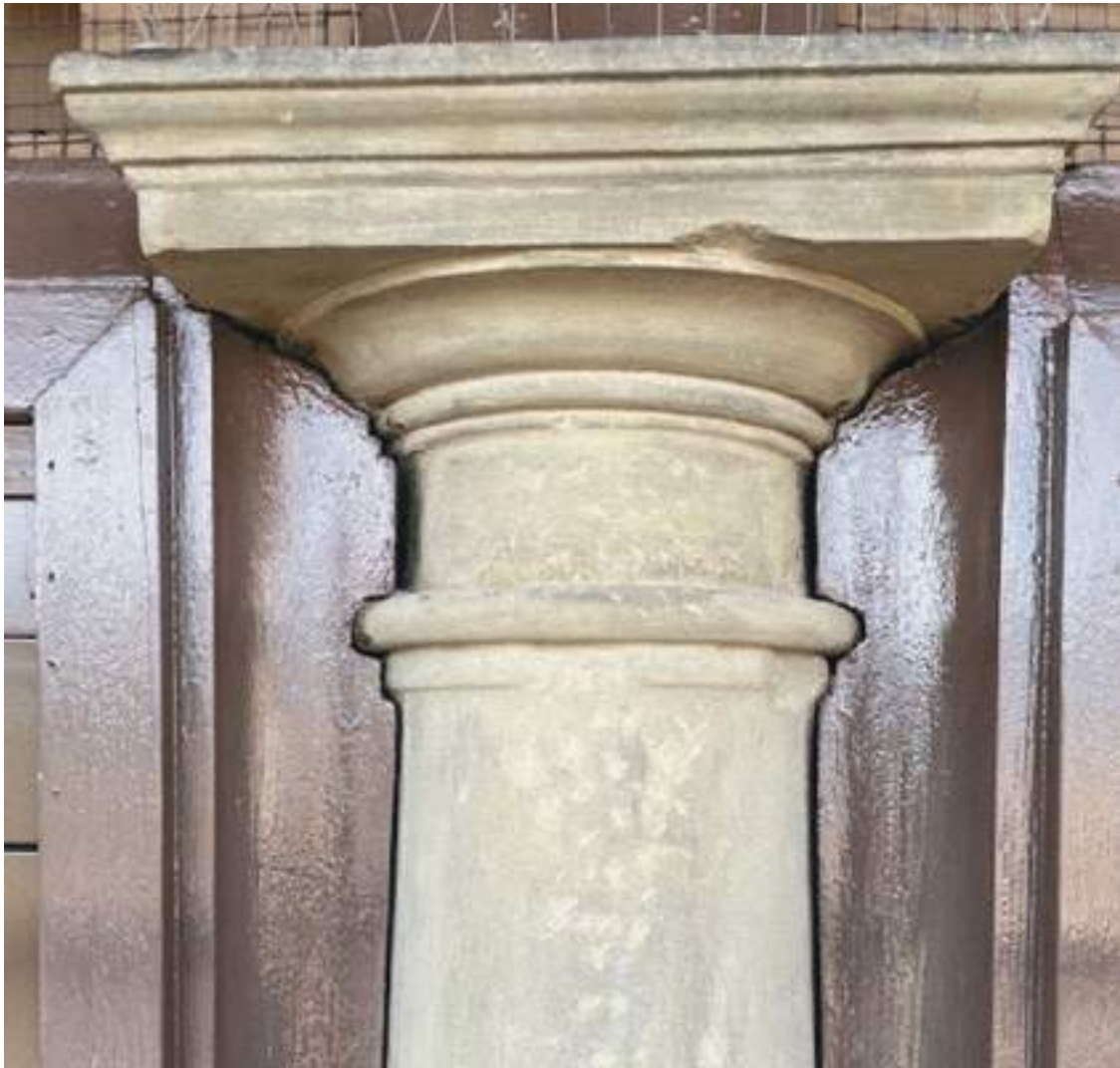
FIG. 8: Il capitello della colonna con la bocciardatura sul fusto per farvi aderire l’intonaco quando la loggia venne murata
