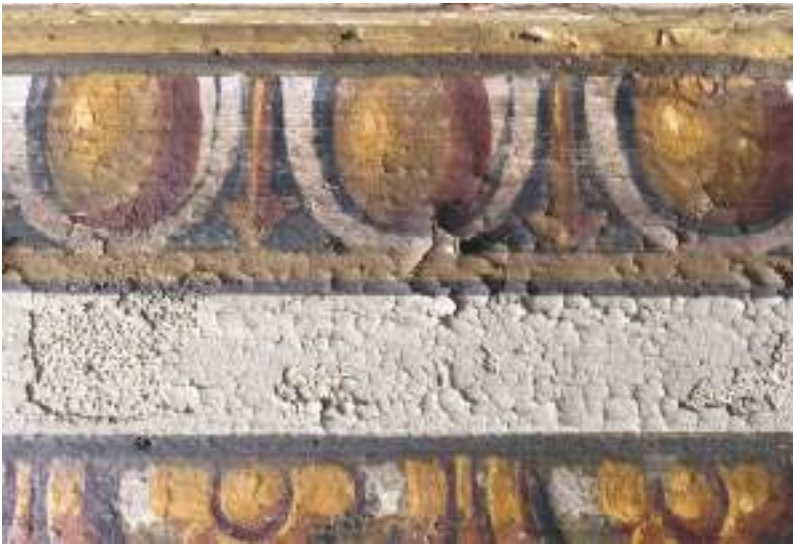
FIG. 12: Particolare della finta modanatura posta nella parte alta della parete, a chiusura della decorazione, dove si osservano i numerosi sollevamenti della pellicola pittorica e ridipinture localizzate nelle perdite di colore
