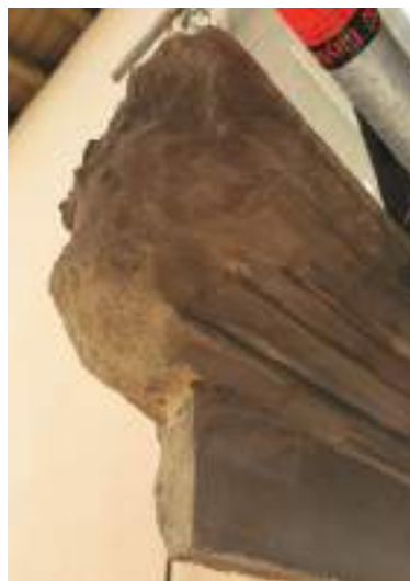
FIG. 3: Particolare della terminazione irregolare della cornice marcapiano fuoriuscente dallo spigolo sud-orientale
