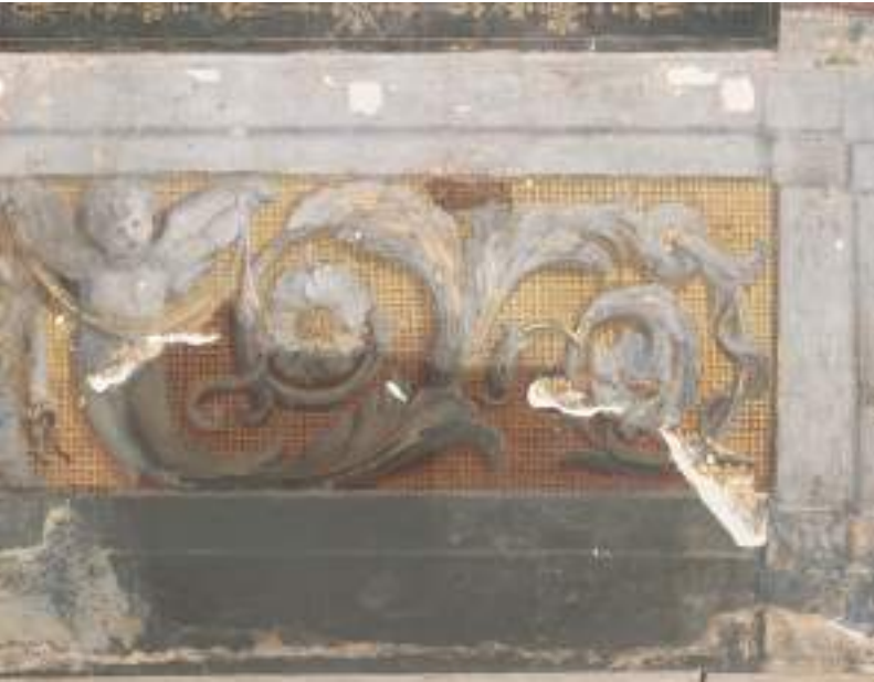
FIG. 23: Particolare di una ripresa di intonaco sul basamento, parete del Dominio vecchio fiorentino
