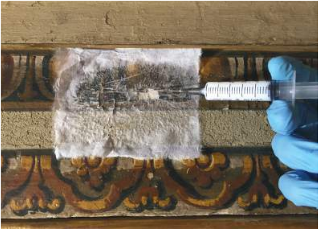
FIG. 16: Preconsolidamento della cornice mediante iniezioni, a tergo delle scaglie, di un adesivo acrilico in emulsione a basse percentuali
