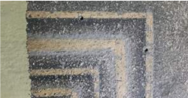
FIG. 5: Particolare dei fori dai bordi stoncati in corrispondenza degli angoli delle linee dei filetti, probabilmente dovuti all’inserimento di piccoli chiodi utilizzati per riportare la ripartizione architettonica delle specchiature
