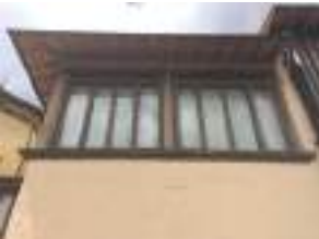
FIG. 7: Il Terrazzo visto dall’esterno. È da notare nella cornice del davanzale la differenza fra la sporgenza anomala oltre il filo di facciata a sinistra e la terminazione di destra
